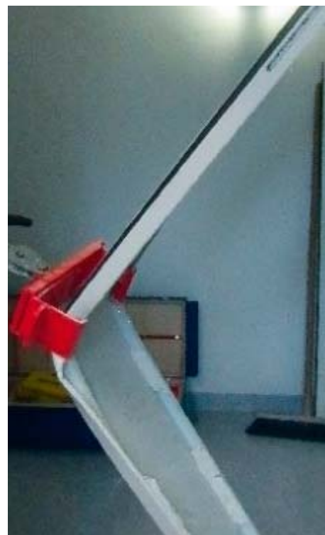
/ Eingeknickte Stahlzarge nach erfolgreichem Einsatz. Hier gut zu sehen: ein Kabelkanal.
